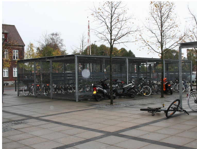
Aflåst, overdækket cykelparkering på Odder Station.
