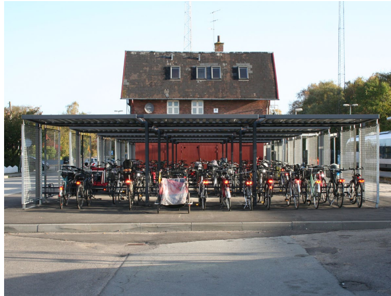
Overdækket cykelparkering tæt på perronen på Hornslet Station.
