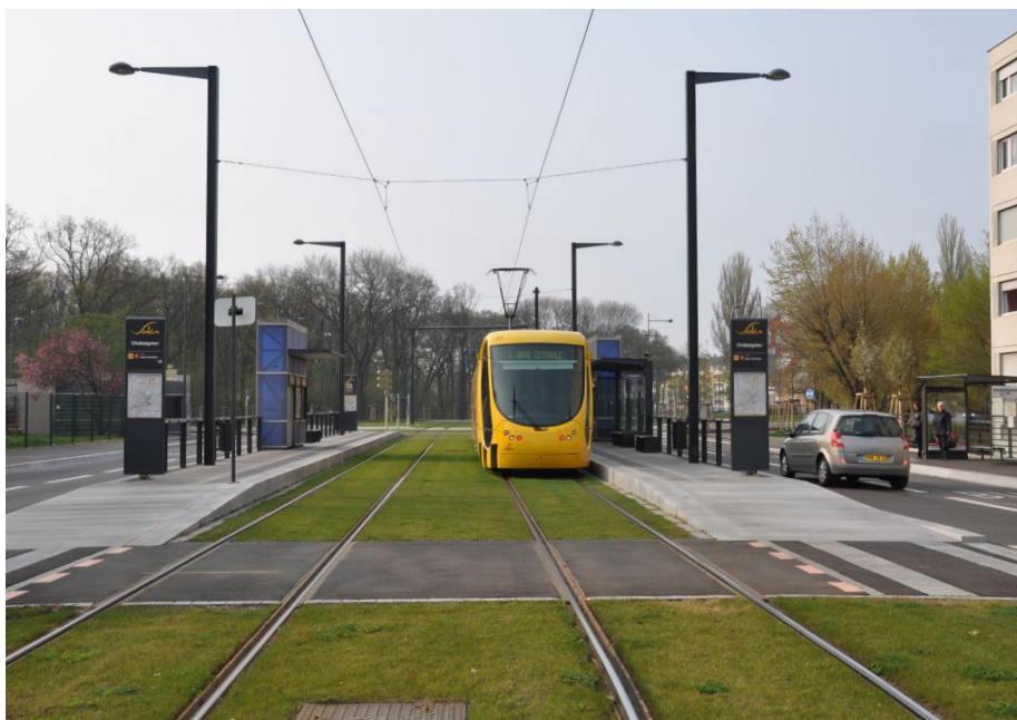
Fodgængerovergange giver passagererne en sikker adgang til en perron i Mulhouse, Frankrig.
