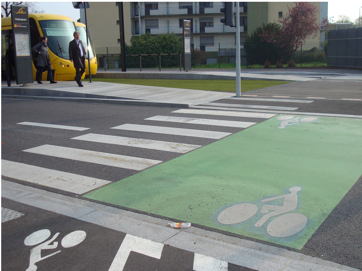
Tydlig markering af fodgænger- og cykelovergang til et standsningssted i Mulhouse, Frankrig.
