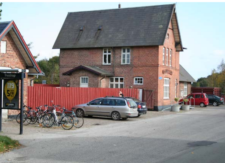
Bilparkering og cykelparkering foran Trustrup Station. Der er tilstrækkelig parkeringspladser, som er placeret tæt på perronen. Der er dog behov for en udskiftning af cykelstativerne, og afmærkning af bilparkeringen vil tydeliggøre disse pladser.
