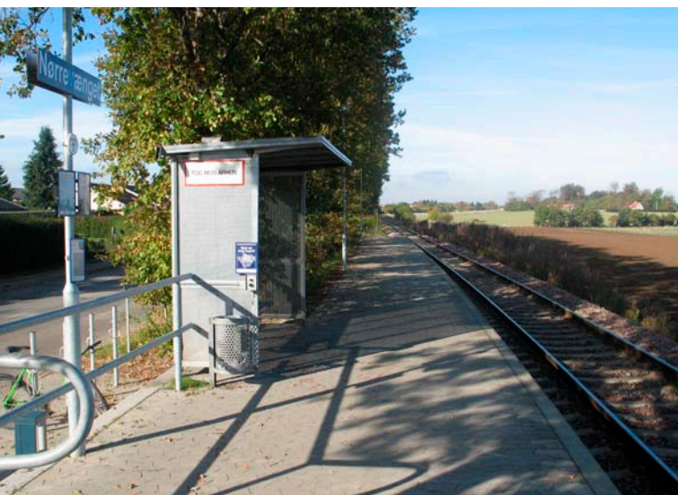
Perronområde ved Nørrevænget Station med cykelparkering og bilkparkering langs med vejen i baggrunden.
